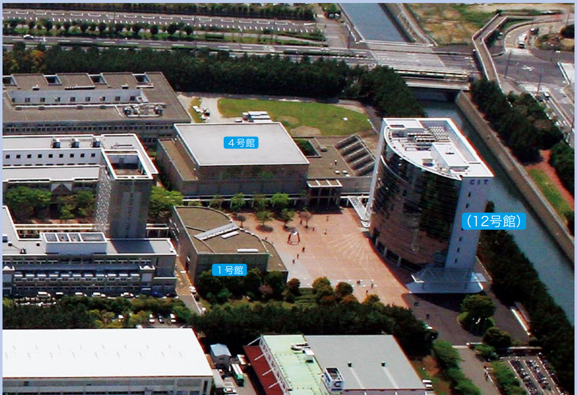
芝園新棟 (12号館) 3月17日竣工
